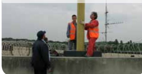
installation des échappements des groupes électriques à travers le bâtiment
