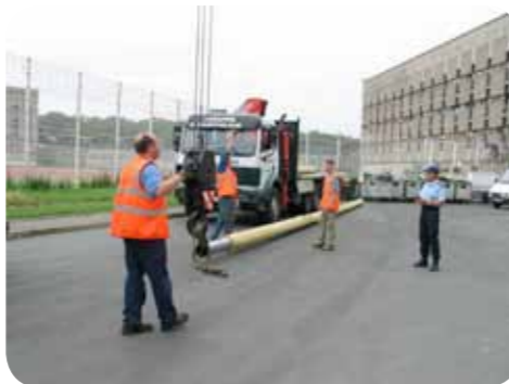
installation des échappements des groupes électriques à travers le bâtiment
