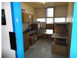
Salle de stockage D4 primo-accueil avant travaux
